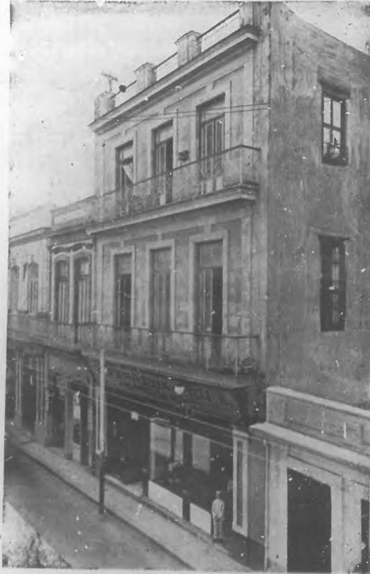
Frente del edificio que en Neptuno 31 ocupa la casa de los señores Loya y Alcerrec.
